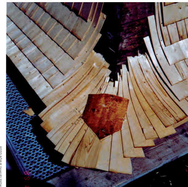
Figur 3.15. Sista lagret i takfotsskiftet med andra skiftets inskott. Spånen nederkant kapades efter att alla spån spikats fast.
