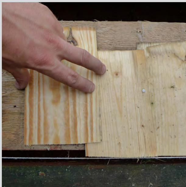
Figur 3.22. Första lagret i fotskiftet lades med 1/3 långa spån. Lagg märke till det vita riktsnöret.
