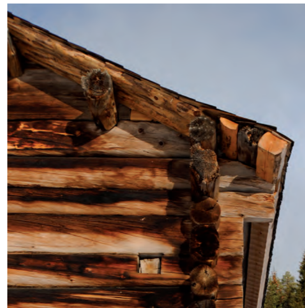
Figur 3.8. Det tunna spåntaket, utan varken vindskiva eller vattbräda, ger det gamla timmerhuset en lätthet.
