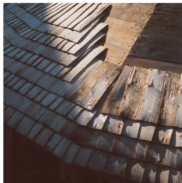
Figur 3.13. Här är vinkeln mellan takfallen relativt liten. Men det är ändå viktigt att spånen även i nederkant ligger omlott med minst 1 tum för att inte vatten ska leta sig in mellan spånen.
