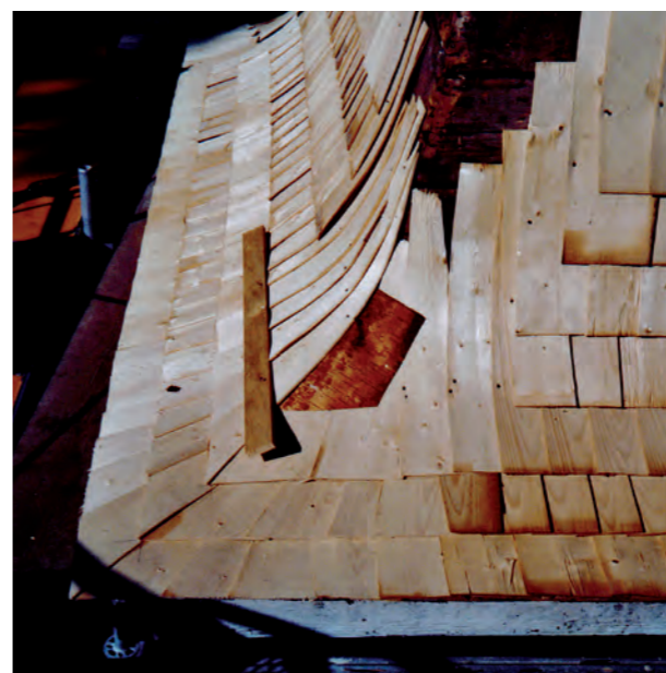
Figur 3.16. Alla skift över hörnet kompletterades med inskott.
