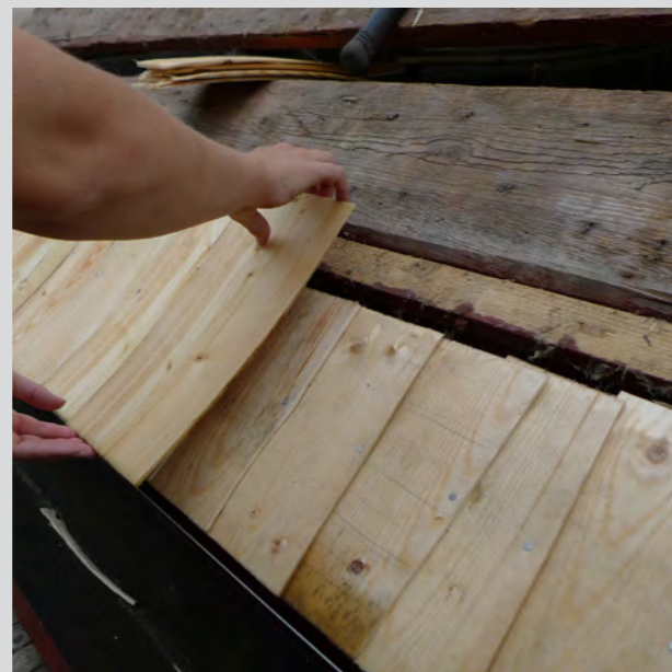
Figur 3.23. Tredje lagret i fotskiftet lades med fulllånga spån. Spånen lades med ryggen nedåt.
