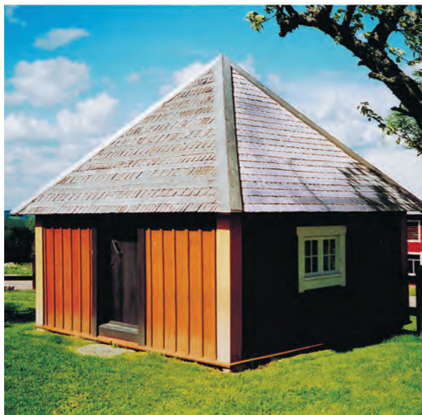
Figur 3.11. När takfallen är raka kan snednocken täckas med nockbrädor.
