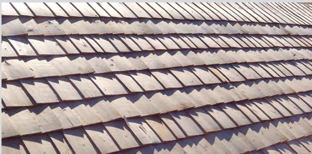
Figur 3.27. Det växelvis lagda taket av granspån.
