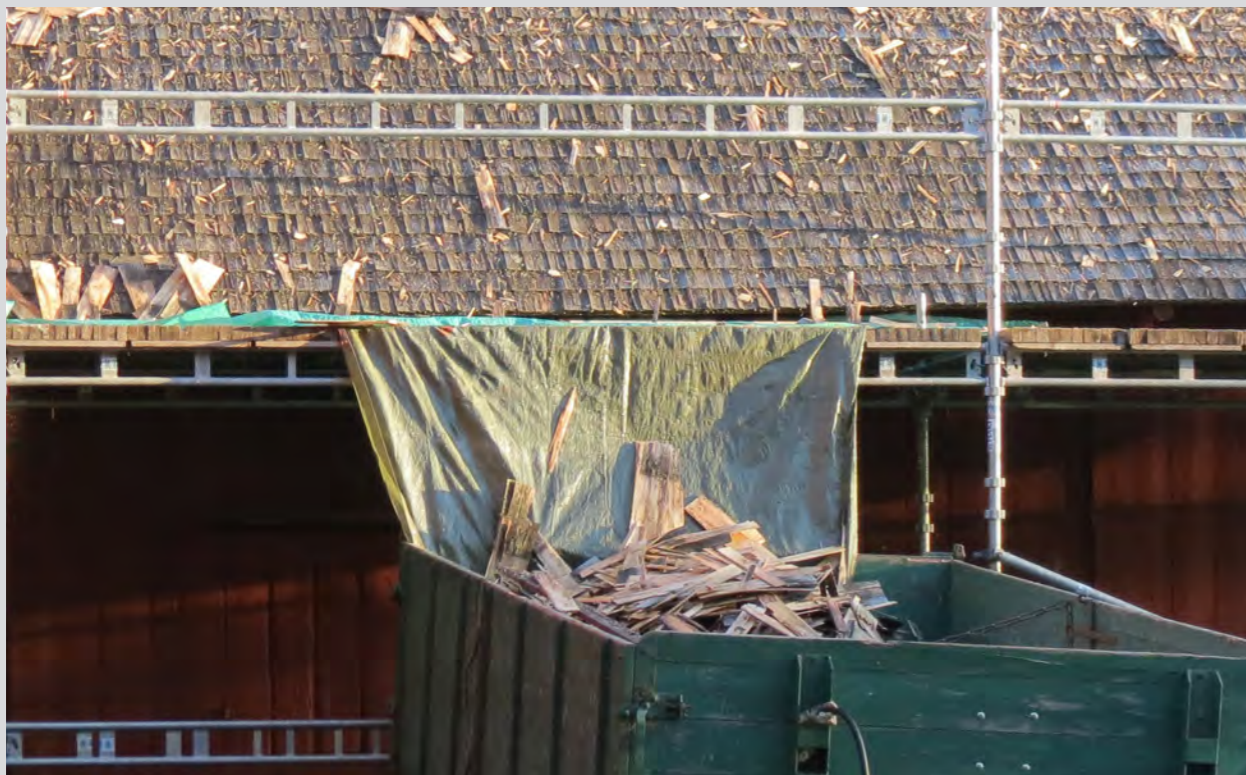
Figur 3.19. Med hjälp av en presenning fördes spån och spik ner i kärran. För att kunna göra det togs ställningens mellanledare och fotlist tillfälligt
