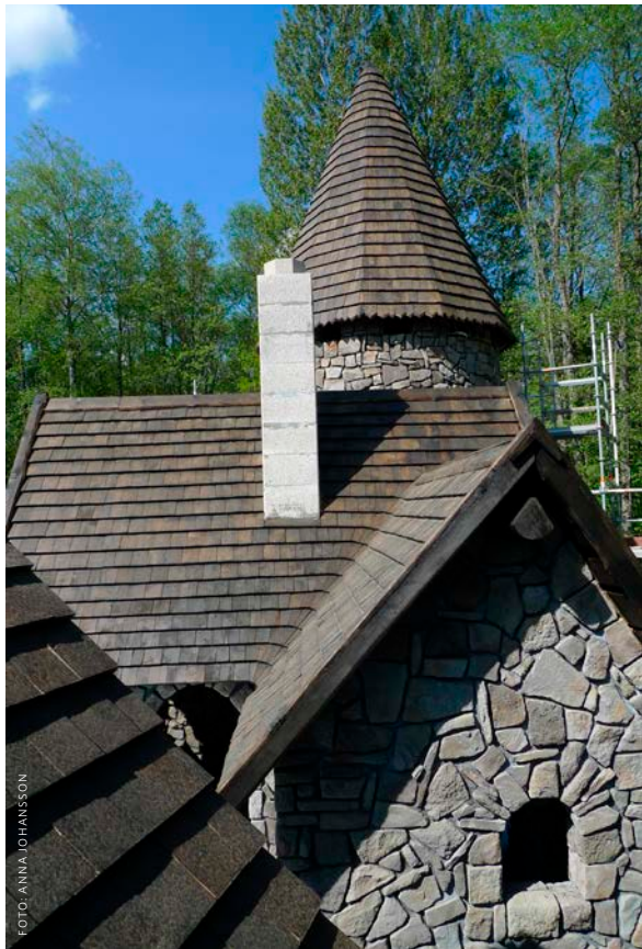
Valet att klä taken med spån är ett lyckat estetiskt drag som skapar en illusion av förgångnen tid.
